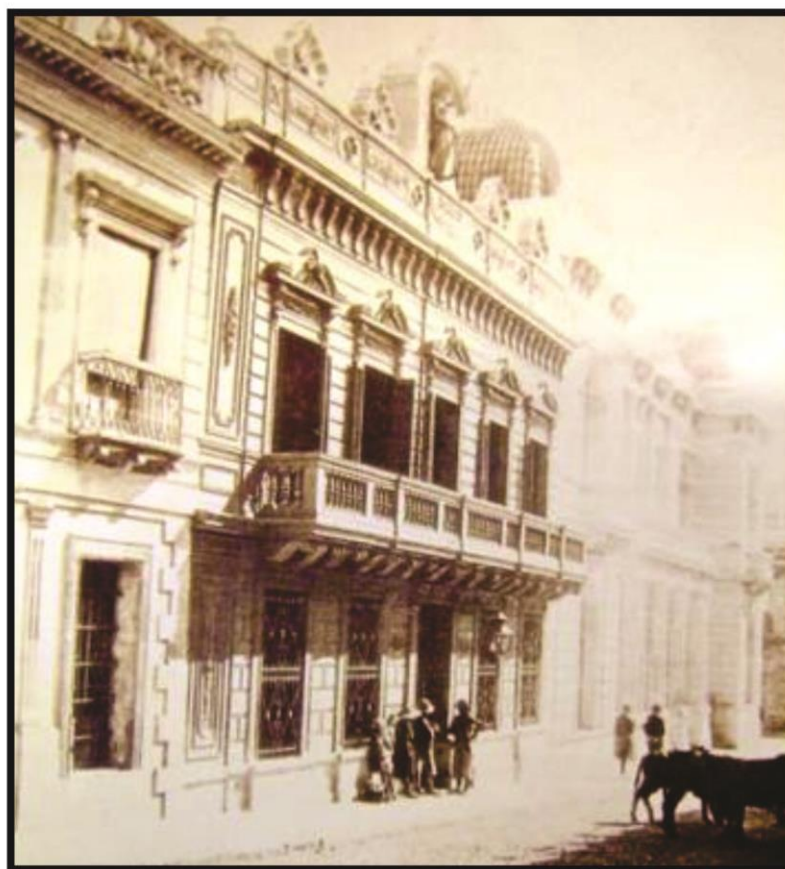
Edificio Argandoña, local del Banco Nacional de Bolivia en Sucre.
